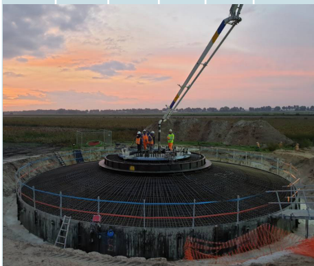
Beton storten RH-3.3
